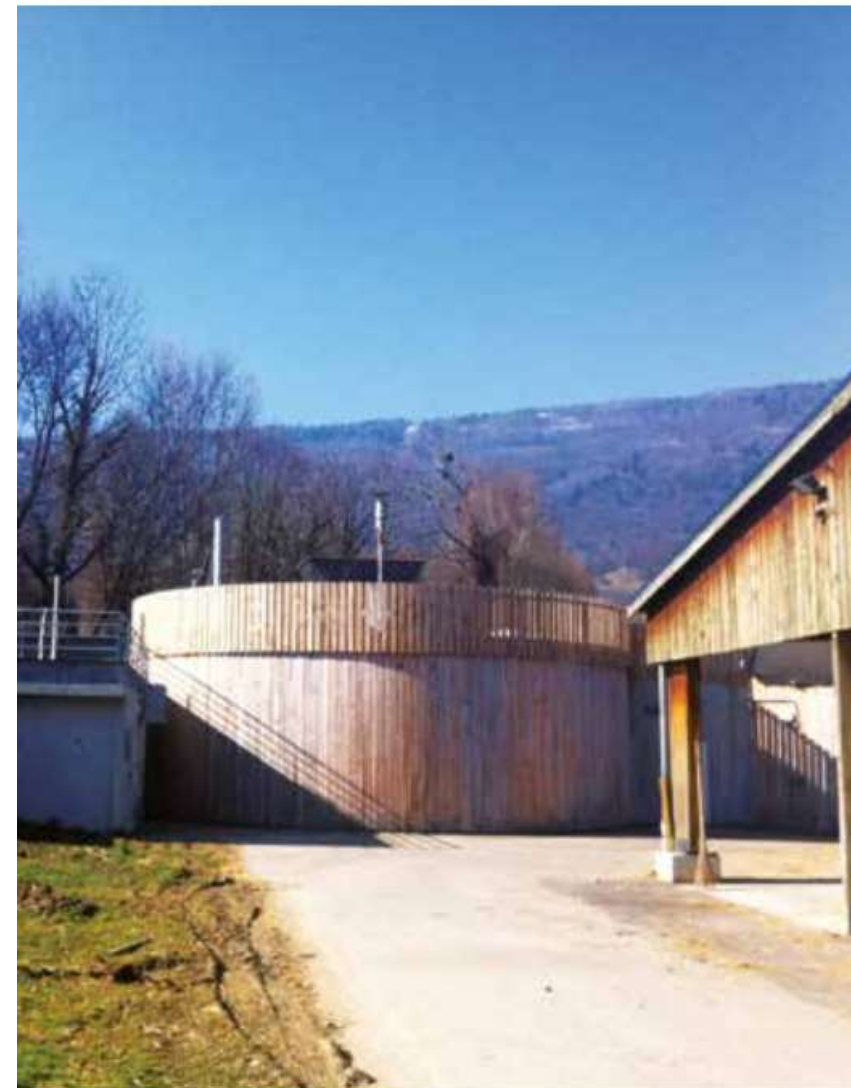
Unité de méthanisation au lycée agricole de la Motte Servolex (73)
